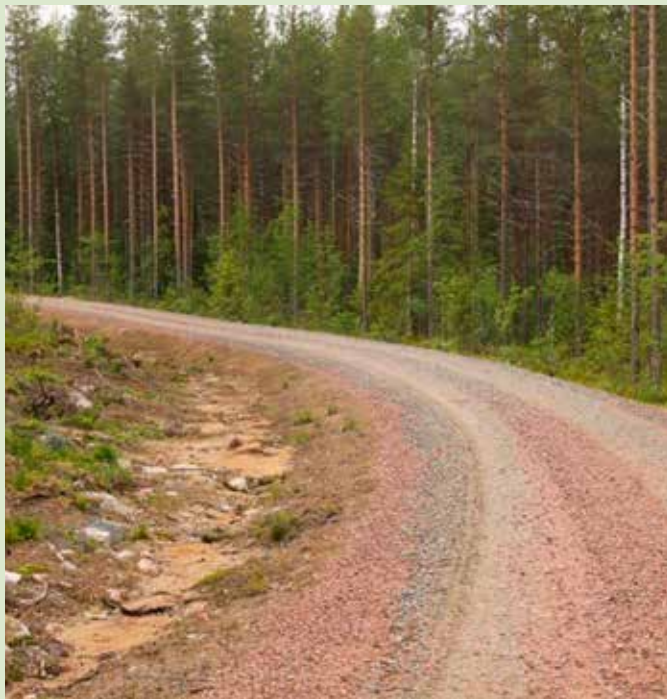
Den här vägen håller sig torr och fin. Vägbanan är rundad så att vattnet rinner av och diken är fria från slam och växtlighet.
