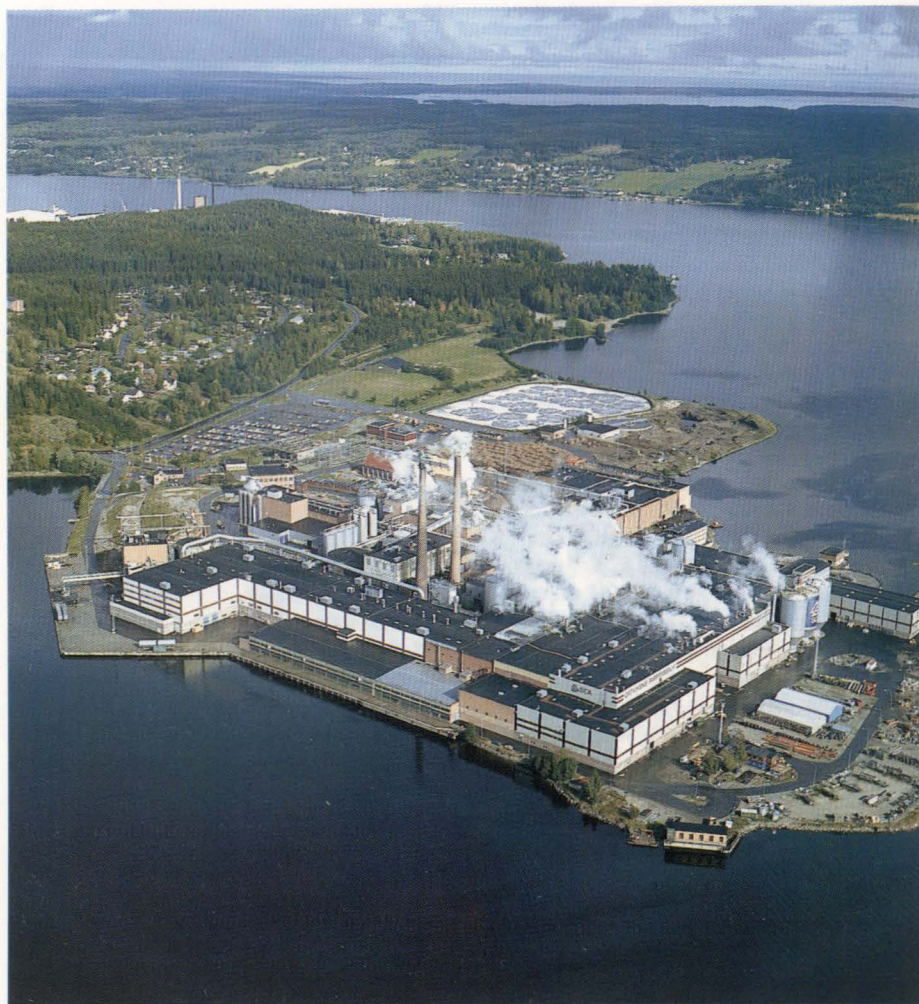
I Ortvisen byggs en tidningspappersmaskin om för produktion av bestruket papper. Produktionskapaciteten blir ca 200.000 ton/år.
