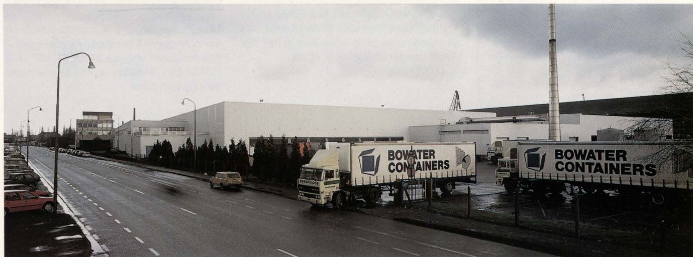
Bowater Containers' anläggningar i Gent
