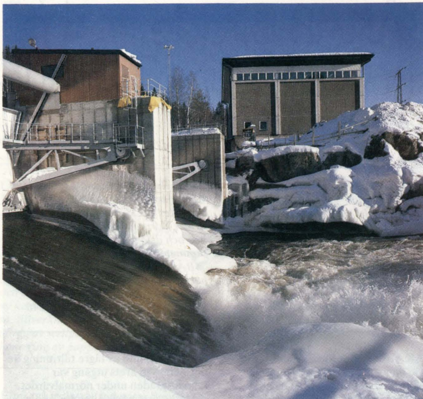
BÅKABs utbyggnad i nedre Ljungan slutförs i och med att Viforsens kraftverk – bilden – tas i drift i oktober 1982. Utöver Viforsen omfattar investeringarna ytterligare ett nytt kraftverk i Matfors samt utbyggnad av Skallböle kraftverk.
