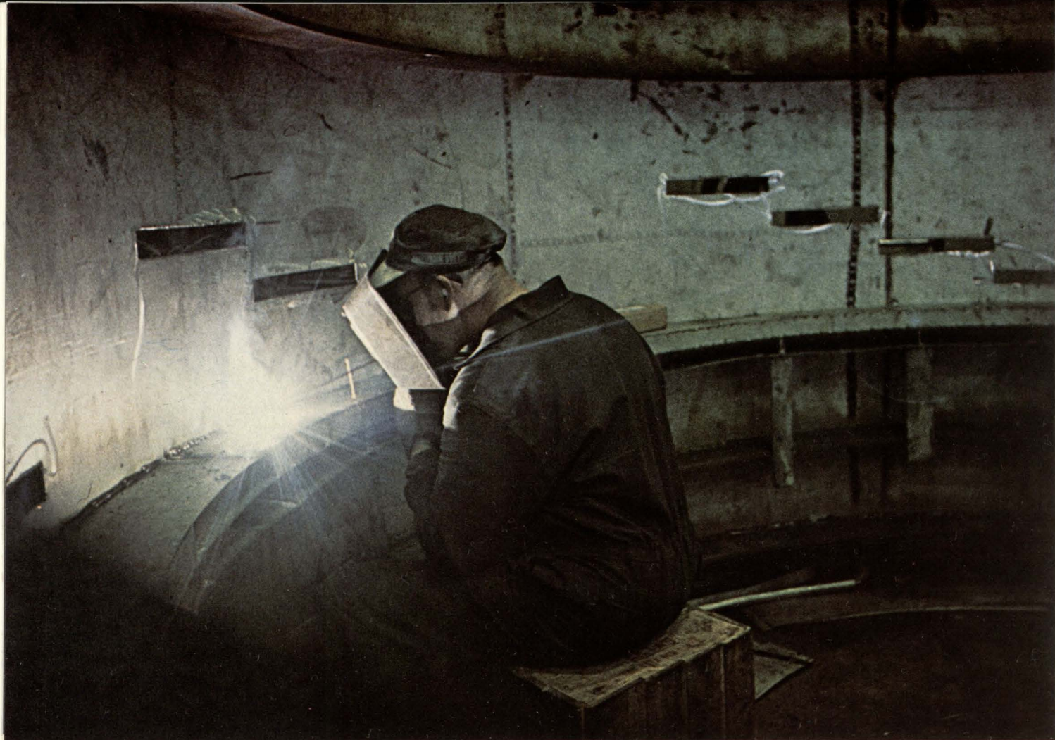
Övre bilden: Svetsning av filter vid Sunda AB:s verkstäder i Sundsbruk, Sundsvall.
