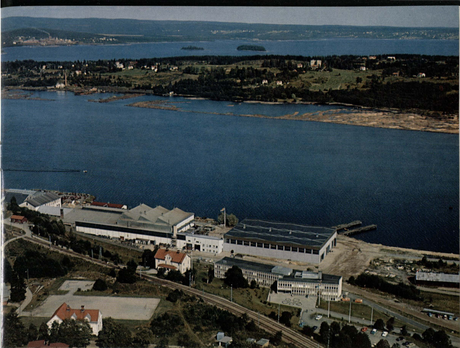
Flygfoto av Sunds Verktäders AB:s anläggningar i Sundsbruk. I förgrunden huvudkontoret, färdigställt 1961.
