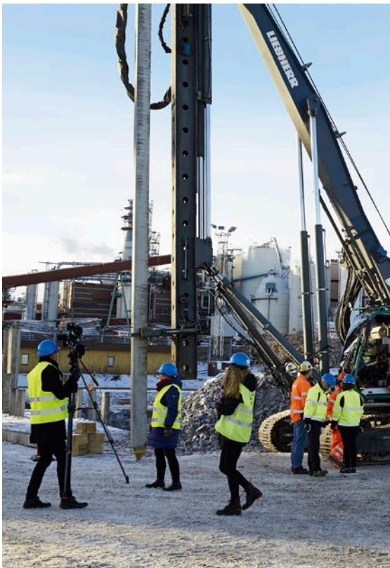
Östrandprojektet invigdes februari 2016 med att en 12 meter lång betongpåle slogs ner i marken.
