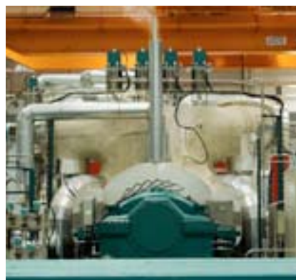
Den nya turbinen i Östrandens massafabrik genererar 0,5 TWh el per år och kommer att förbättra SCAs energibalans.
